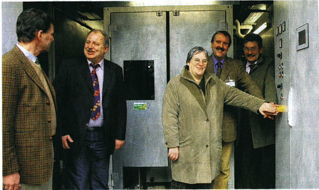
Bürgermeisterin Hedwig Klein drückte gestern symbolisch den Einschaltknopf fürs neue Blockheizkraftwerk, flankiert von Stefan Haarhoff (Saat-Energie), Rainer Sender (West), Dion Feiter (Saat) und Markus Palic (West). RP-FOTO: LAASER
